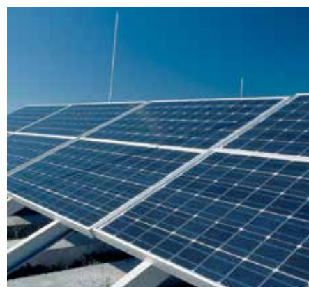
Solar cell array
